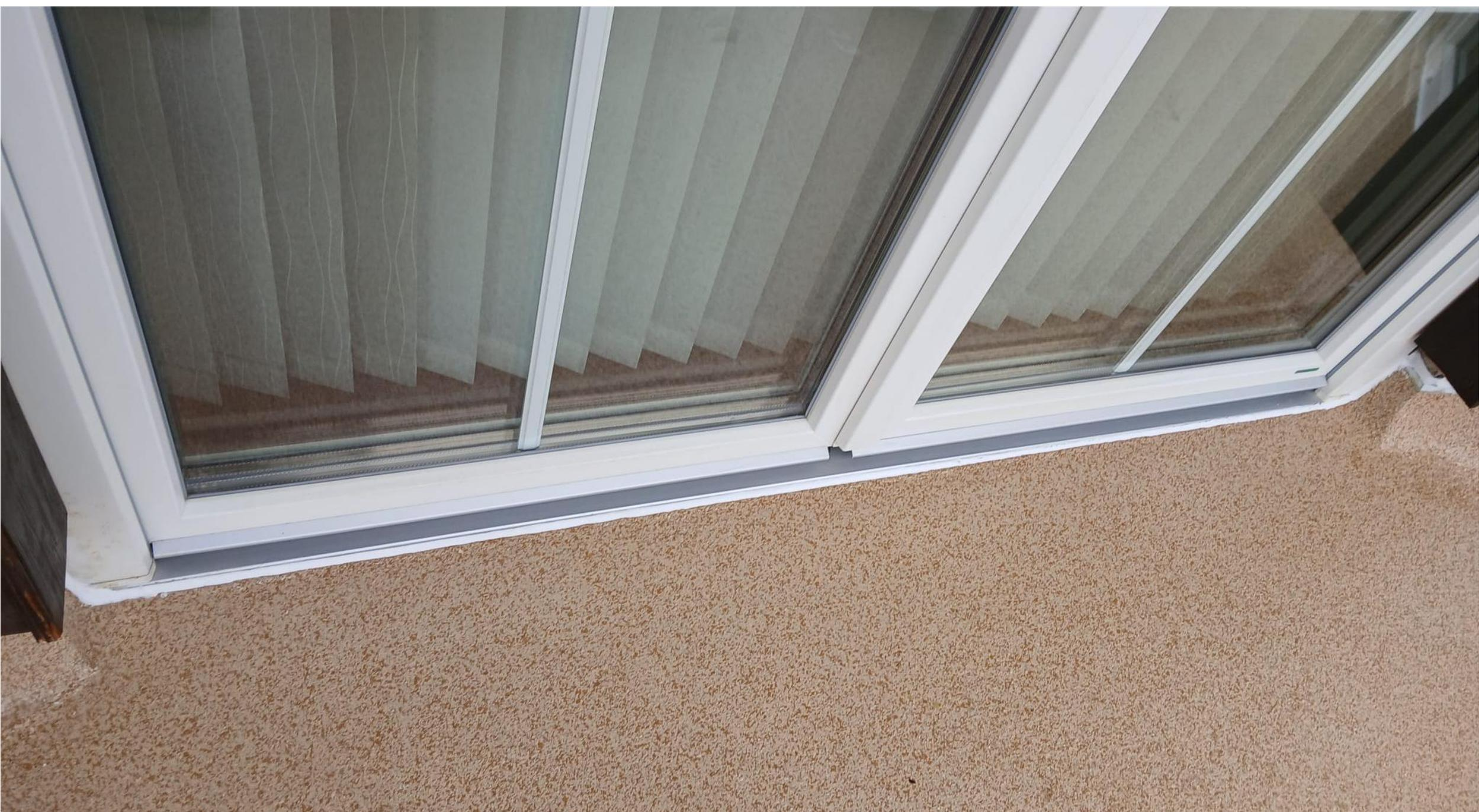
PMMA Balkonsystem Chipsbelag
